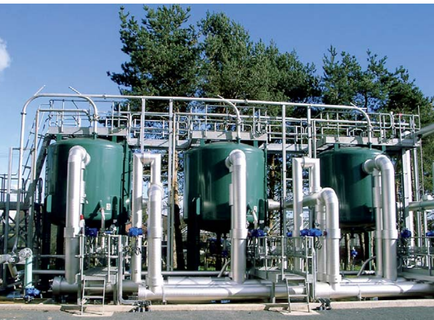
Abbildung 9: Anlage eines Festbettreaktors aus Eisenhydroxidoxid-Granulat Bayoxide® E33 mit sehr fein strukturierten Oberflächen im Nanobereich zur Arsenadsorption (Quelle: Bayer AG, Severn Trents Services)
