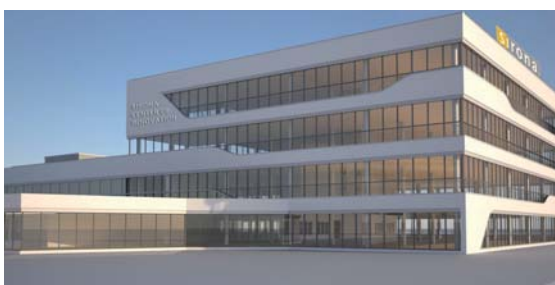
Der Neubau des Sirona Innovationszentrums in Bensheim (Quelle: Sirona)
